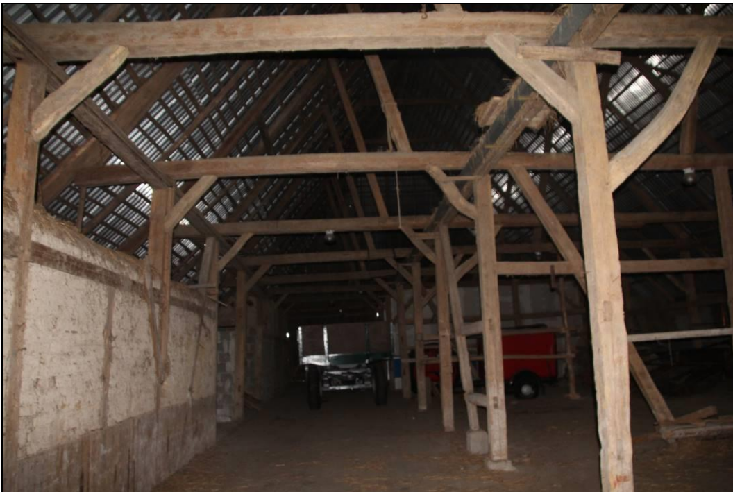
Abbildung 13: Ansicht des Inneren der Scheune
