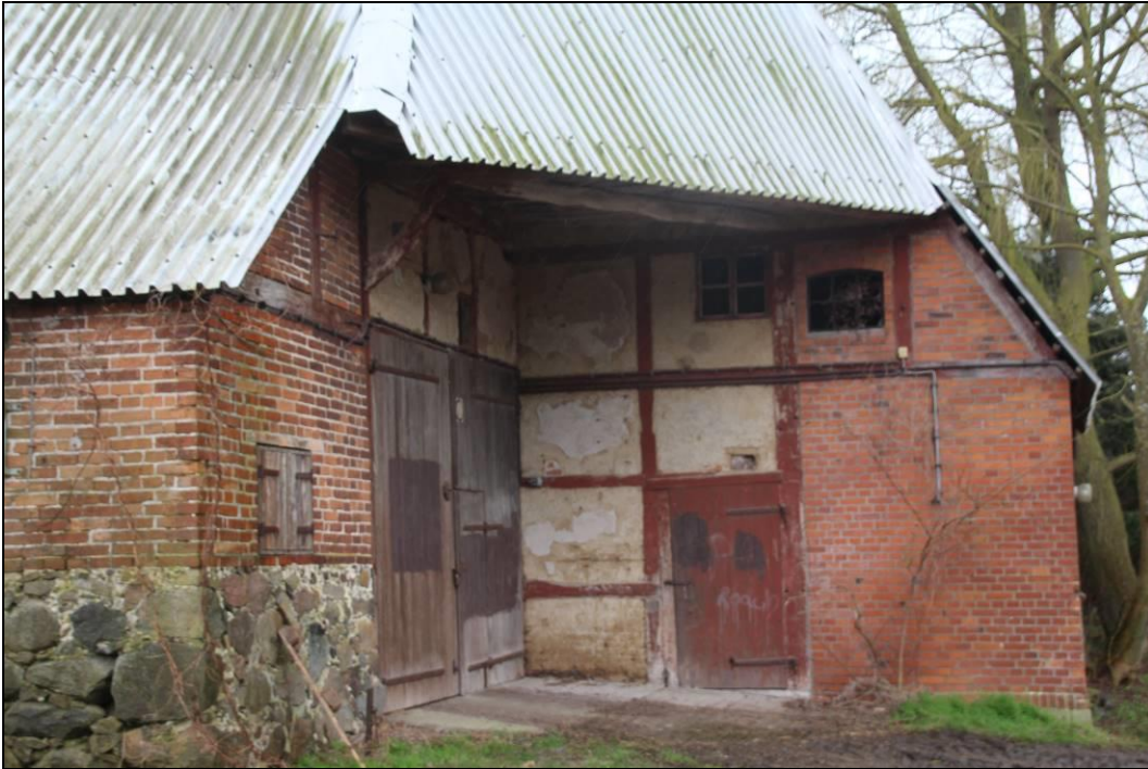
Abbildung 12: Ansicht des Eingangsbereiches der Scheune
