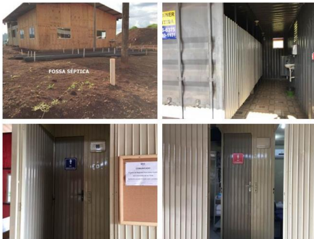
Figura 42 – Banheiros internos e fossa séptica.
