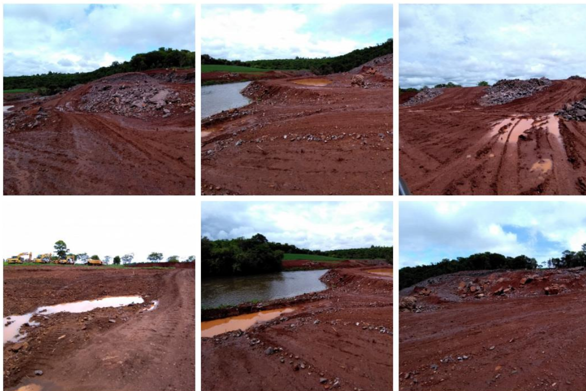
Figura 4 – Taludes presentes na região do barramento.
