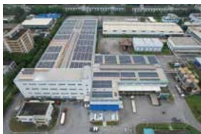
目前，广州工厂已安装了近3000块太阳能电池板(照片由阿克苏诺贝尔提供)。
