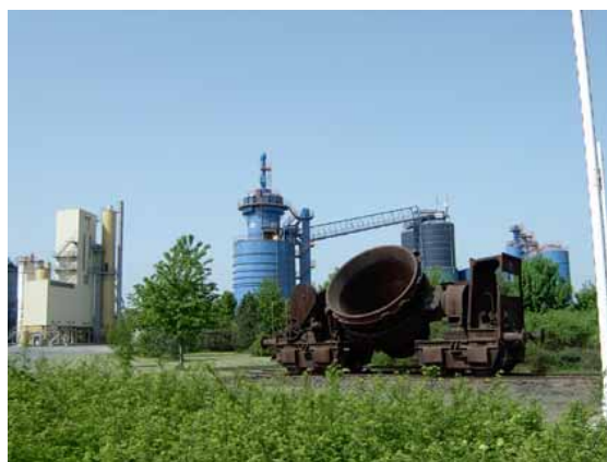
Abb. 23: Schlackfanganlage Ilseder Hütte (Ilsede)
