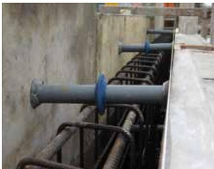
UFO hinchable para el sellado estanco y resistente a la presión de grietas de hormigón alrededor de distanciadores de encofrado hasta 6 bar.
