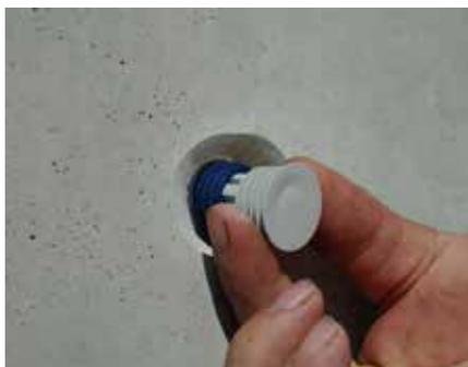
Tapón hinchable para la estanqueidad y la resistencia a la presión de los distanciadores de encofrado hasta 6 bar. Adecuado para purines y estiércol líquido.
