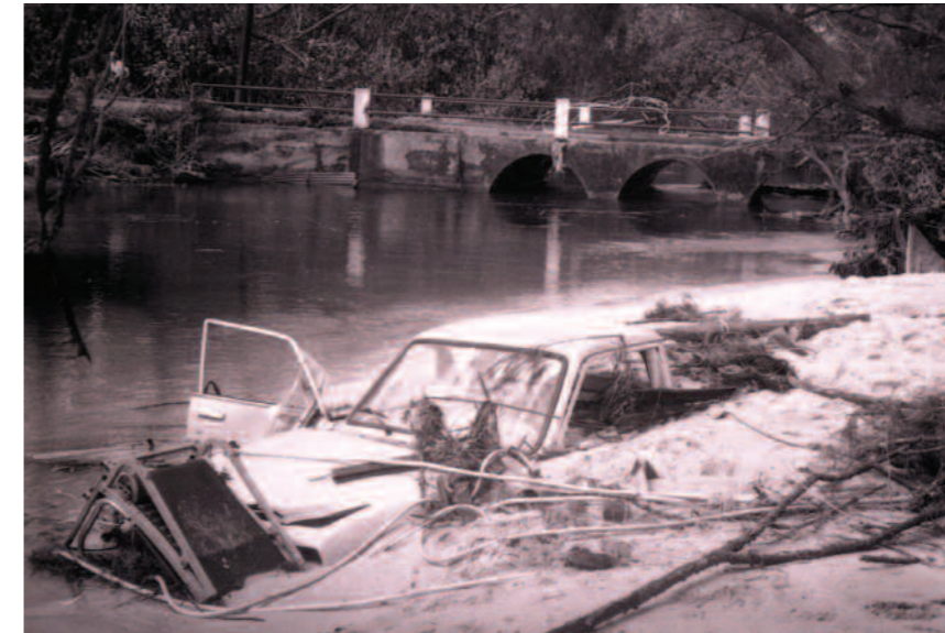
PHOTO 1 Dégâts générés à Tubuai par la marée de tempête et la surcote générées par le cyclone William en 1995. © La Dépêche du vendredi 6 janvier 1995
