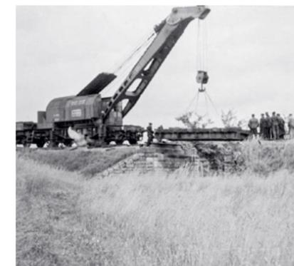
Abb. 07 · Abbau der Eisenbahnbrücke Oberuhldingen. 1960er Jahre.
