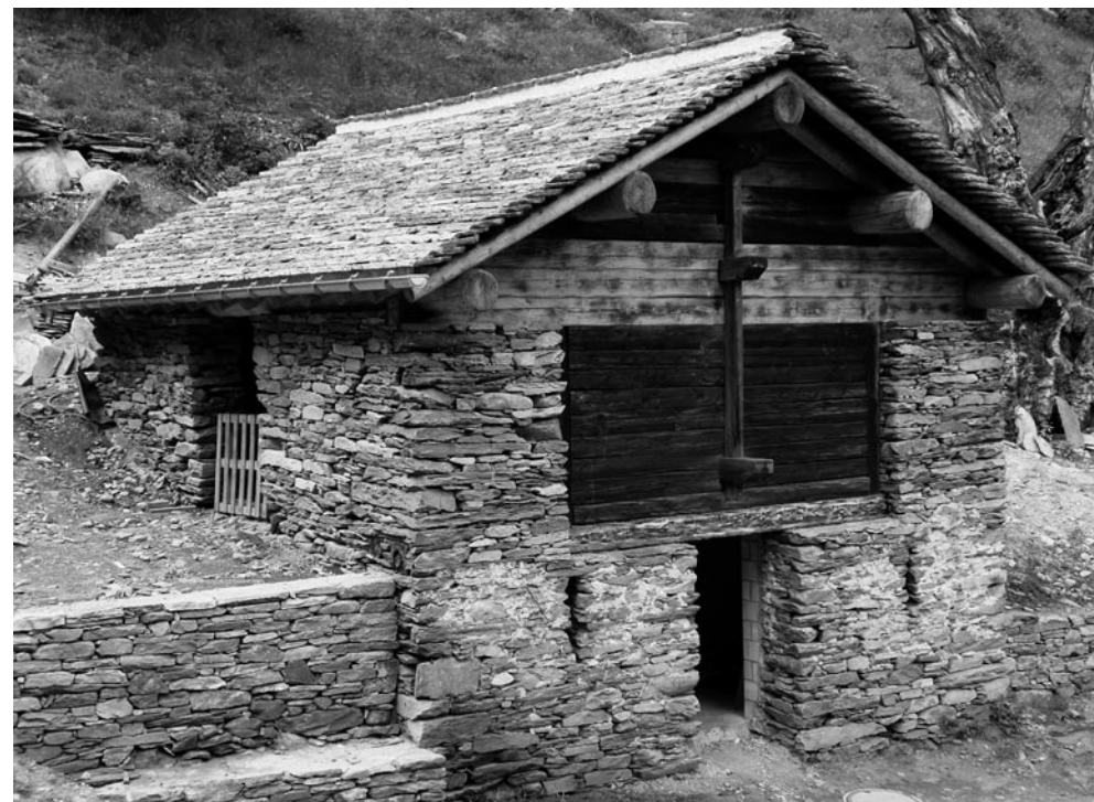
Refettorio del Centro didattico in costruzione. Foto: Ivano Fasani
