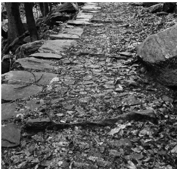
Tecnica particolare per compattare il selciato
