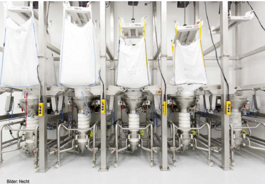
Insgesamt installierte das Unternehmen im Zuge des Projekts zehn Big Bag Entleerstationen.
