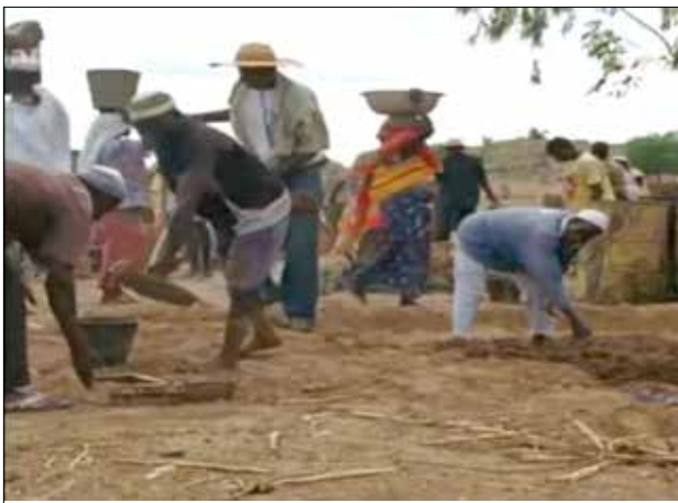
Ziegelproduktion in Burkina Faso (Bau einer Krankenstation), ...
