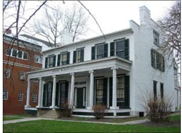
Davis Hall exterior.
