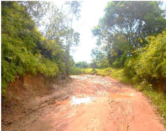
Figure 4. Dégradation de la piste rurale
