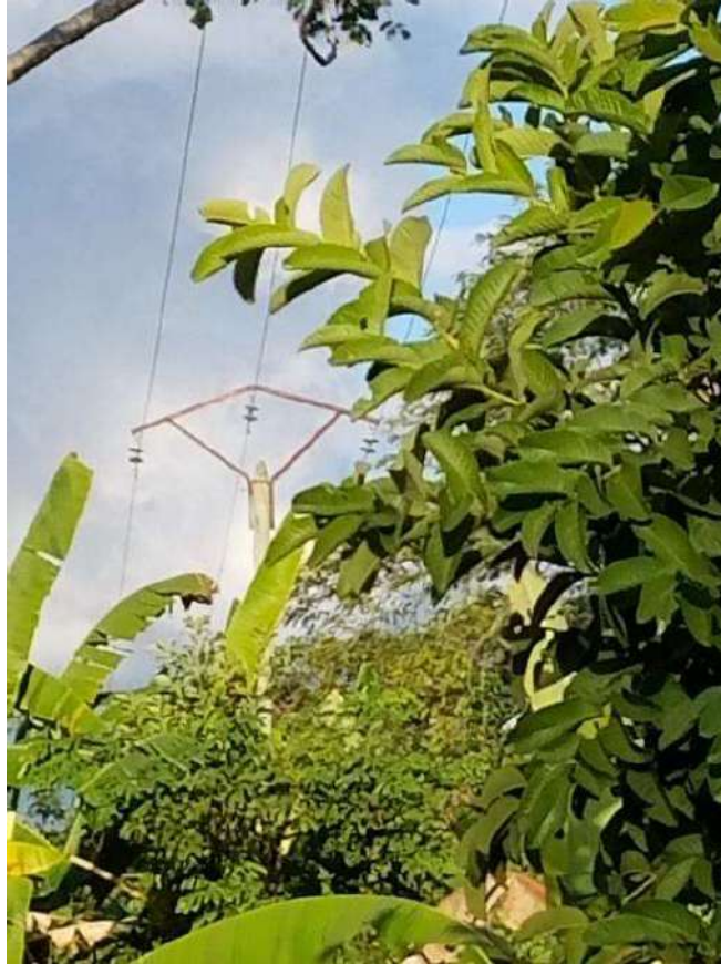
PHOTO 4-1: LIGNE EXISTANTE (AMBANJA) A REHABILITER
