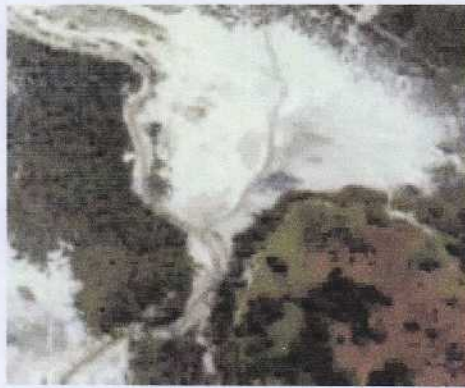
Imagen 1. Imagen aérea de la zona de colmatación del cauce por deposición de material de arrastre.
