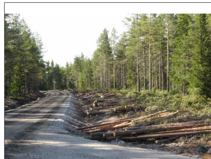
Förberedande avverkning inför kabelförläggning i mark längs vägen på Bondön (foto: Kerstin Boström, ÅF).
