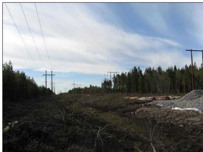
Breddning av kraftledningsgata på Pitholmen inför anslutningen av vindkraftverken på Bondön 2008 (foto: Kerstin Boström, ÅF).
