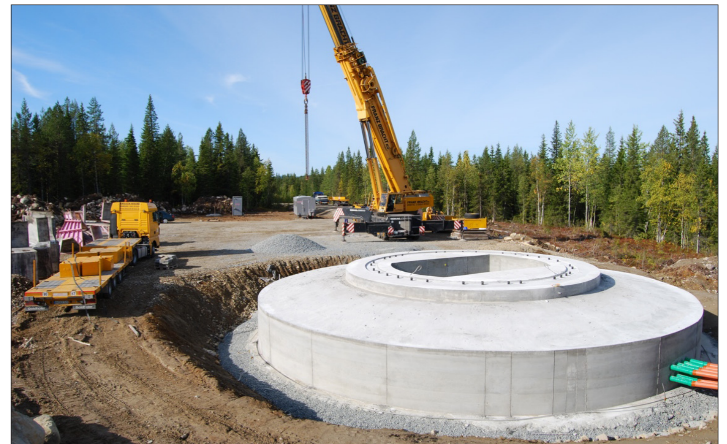
Fundament (foto: Jonas Lundmark).
