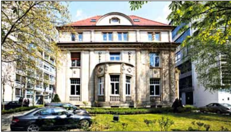
Bis zum kommenden Frühjahr soll die Sanierung abgeschlossen sein
