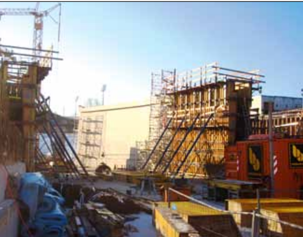
Die Bauarbeiten sind im vollen Gange
