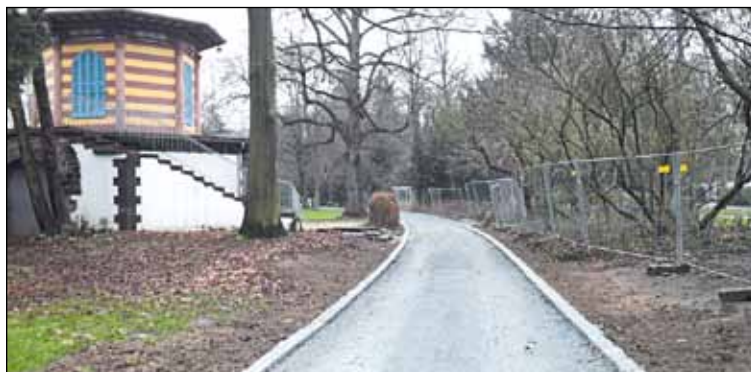
Unter anderem wurden die Wege im Grüneburgpark grundlegend saniert (hier neben dem Schönhof-Pavillon)
