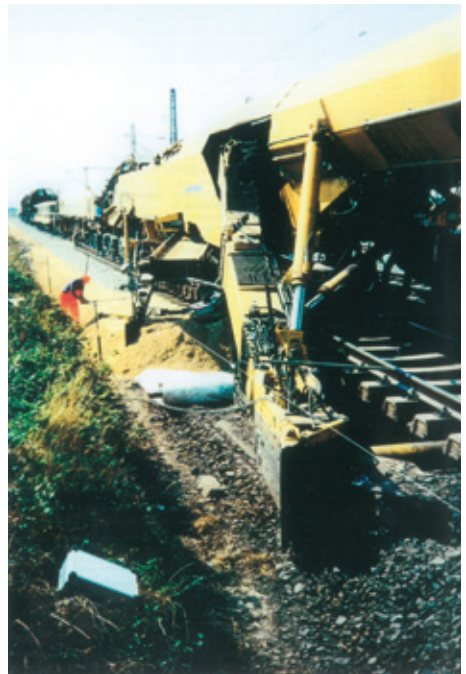
Abb. 20: Einbau von Verbundstoff und Kiessand mit der PM 200 im Jahre 1993
