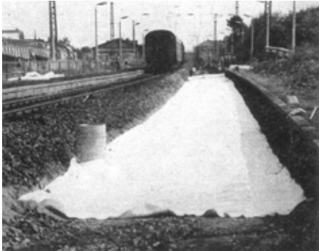
Abb. 16: Einbau eines Vliesstoffes auf dem Erdplanum 1978
