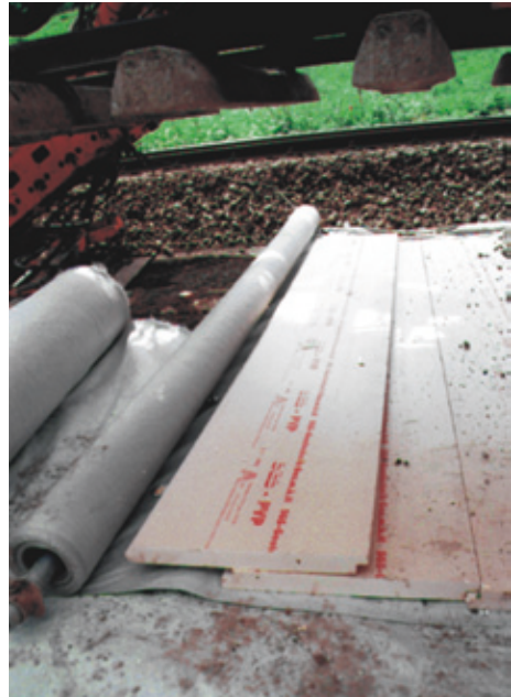
Abb. 13: Schichtsystem aus Vliesstoff, Hartschaumplatten und Kiessand
