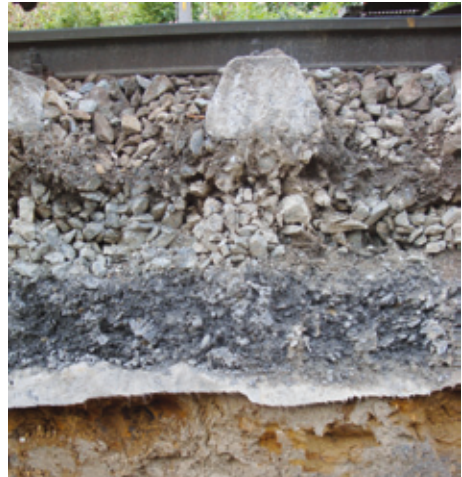
Abb. 10: Zustand des Schichtsystems mit Vliesstoff nach 23 Jahren
