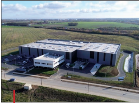
La nouvelle usine SIMP de Tigery. Les 14 000 m 2 de terrain environnant donneront toute latitude d'extension ultérieure.
