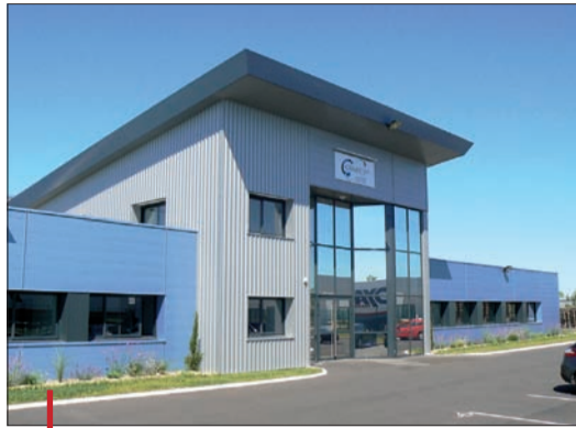
Comep dispose de 6 500 m 2 de locaux à Cognac.
