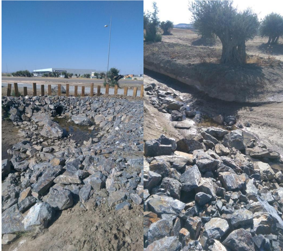
Figura 11. Escollera de rocas de síliceas, generación de hábitats para vegetación edafoxerófila.
