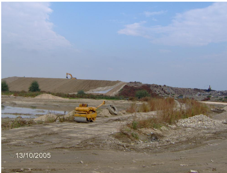
Сн. 3.2.3-4. Клетките на депото за ТБО в с. Цаланица, на които се извършва техническа рекултивация
