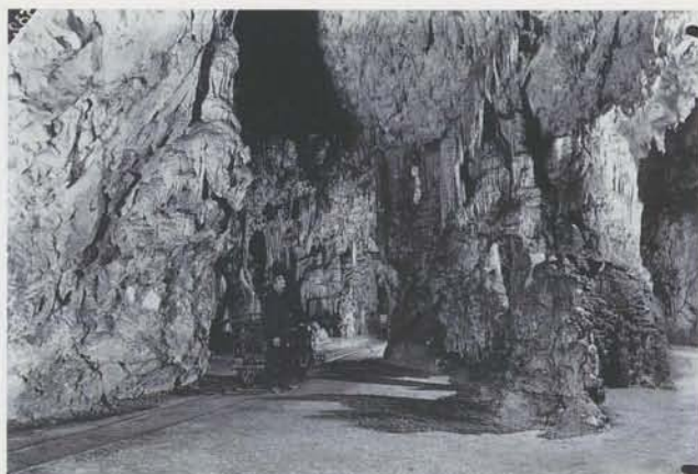
7 Jamski voziček "faeton" in vodnik po jami leta 1872. Postojnska jama (Pot k plesišču). Prva podzemeljska železnica je stekla 16. junija 1872. Pobudo za gradnjo železnice je dal Anton Globočnik; železnica je potekala od vhoda v jamo do vznožja Kalvarije (približno 1,5 km)
