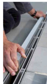
Esempio di montaggio della barra LED nella caditoia a fessura
