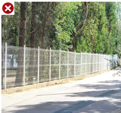
Clôture grillagée normalisée blanche
