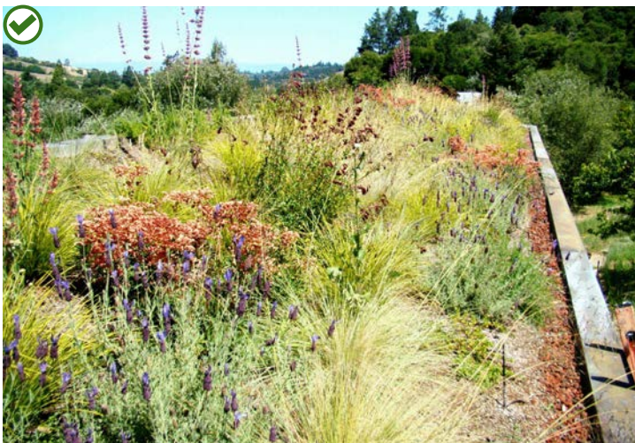
Toiture plantée - substrat 15 à 25 cm
