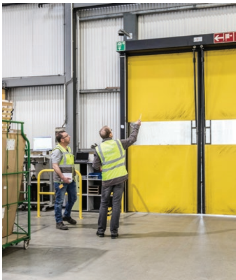
Die Schilder weisen den Weg zu einem Löschposten. Ein Durchkommen ist jedoch unmöglich, weil er komplett zugestellt ist.
