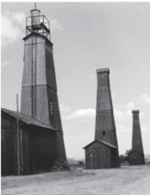
Zuerst Salz-Bohr- und dann Sole-Fördertürme; diese erinnern an die erste industrielle Revolution in Pratteln. Heute existieren nur noch zwei Türme.
