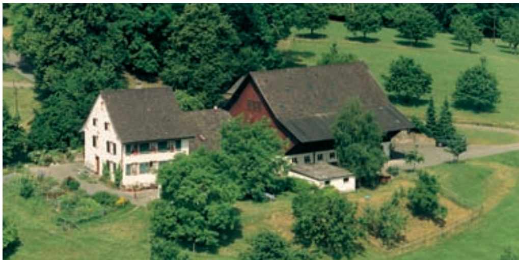
Der Ebnet ist der älteste Nebenhof; er befindet sich im Besitz der Bürgergemeinde Pratteln und dient heute als Werkhof und Försterwohnung der Bürgergemeinde.
