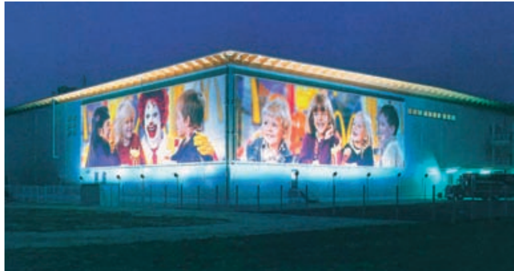
Die Prattler Traditionsfirma Häring & Co. AG hat sich von einem holzverarbeitenden Betrieb zu einem innovativen Bauunternehmen entwickelt. Das Bild zeigt das durch die Häring & Co. AG, Innovatives Bauen, realisierte Logistikzentrum von Mc Donalds in Oensingen.
