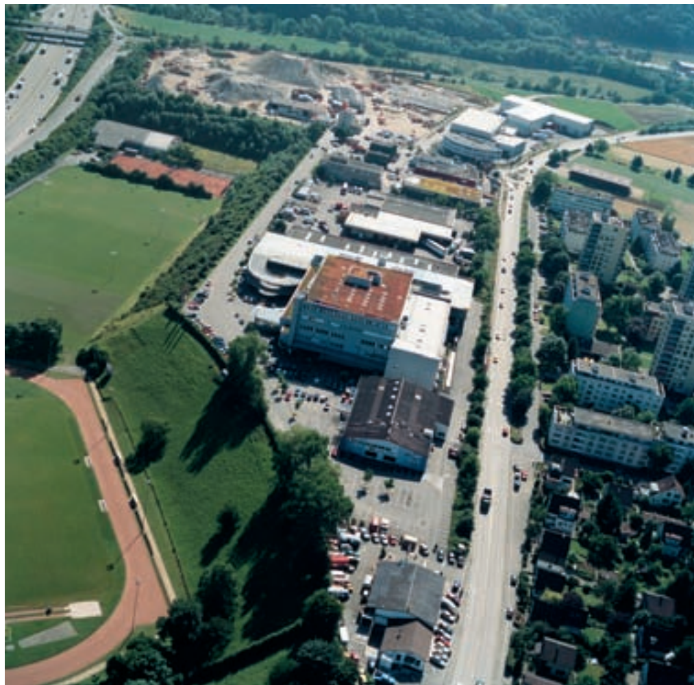
Die Parzellen in den Gebieten Rüti und Wanne, links von der Strasse Pratteln–Frenkendorf, sind von der Bürgergemeinde im Baurecht abgegeben worden. Oben links die Autobahn A2.
