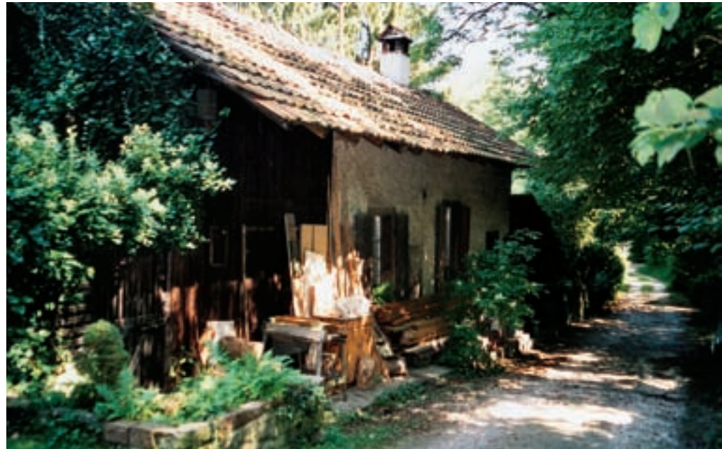
Das Fährnhaus der nicht mehr betriebenen Fähre Schweizerhalle–Grenzach.
