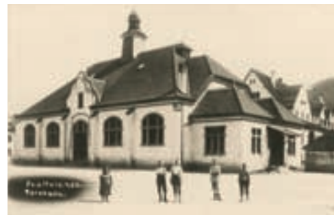
1906 wurde gegenüber dem Schloss-Schulhaus die im Jugendstil gestaltete Turnhalle erbaut.
