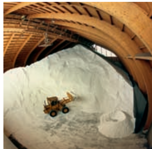
Eine Industrie-Kathedrale als Salzlager. Die Dimensionen der futuristischen Lagerhalle sind aus dem Vergleich mit dem Pneu-Lader ersichtlich.
