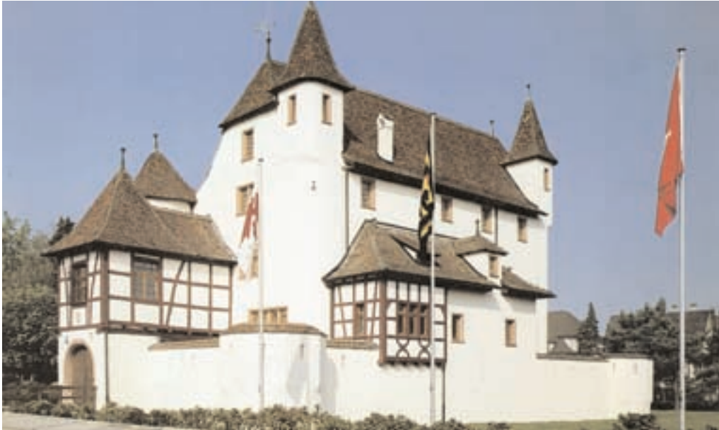
Das Prattler Schloss nach der Renovation von 1967.
