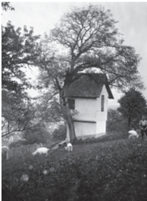
Das älteste Prattler Rebhäuschen, das vom Pfarrer Hagenbach im 17. Jahrhundert erbaut und 1952 total neu aufgebaut wurde. Foto vor 1952.
