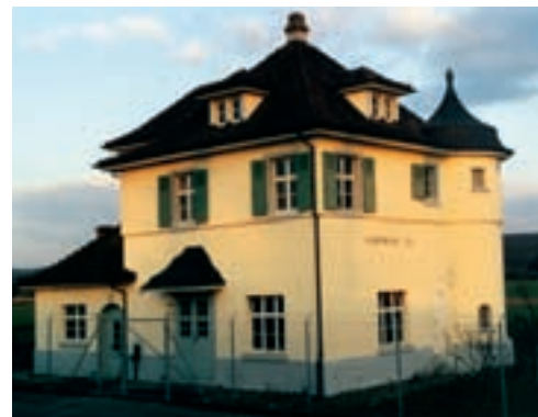
Das 1913 im Jugendstil errichtete Pumpwerk Löli.
