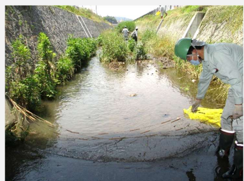
防除作業に伴う断片の流出防止のためのネット設置
