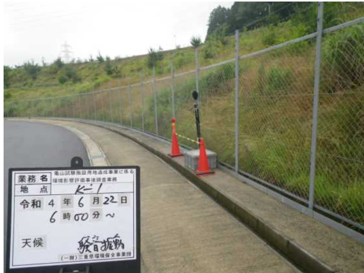
写真①-1 騒音・振動調査状況 (K-1：令和4年6月22日)
