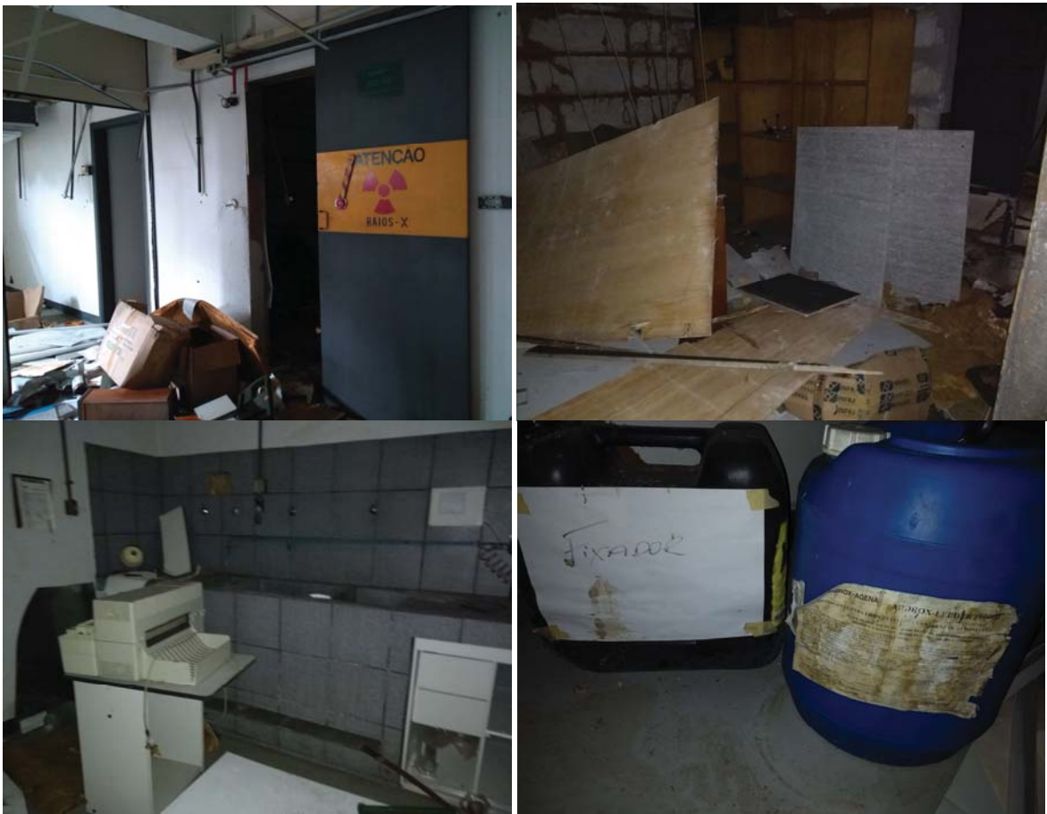
Fotos 75 a 78 – Área de raio x e dos produtos químicos utilizados para revelação do raio x.
