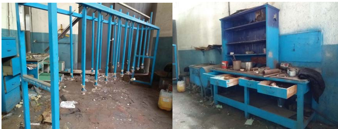
Foto 28 e 29 – Maquinário, móveis antigos e material abandonado na área de jateamento.
