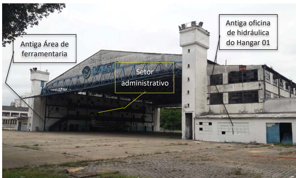
Foto 1 – Vista geral do Hangar I (AF-01).
