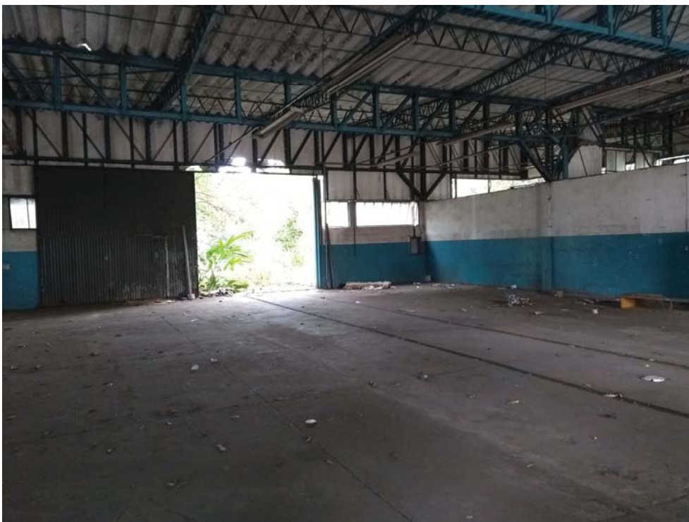
Foto 33 – Antiga área de polimento, totalmente desocupada, com marcas no piso de antigos equipamentos.
