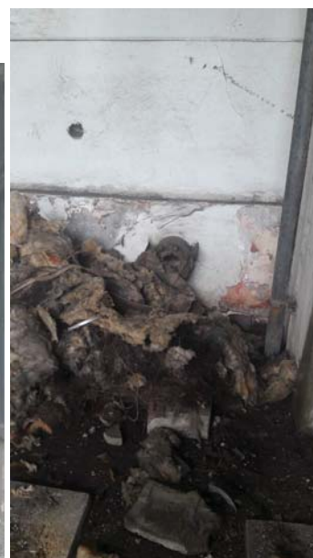
Fotos 67 e 682 – Estrutura que abrigava a caldeira e resíduos da desmontagem da caldeira.
