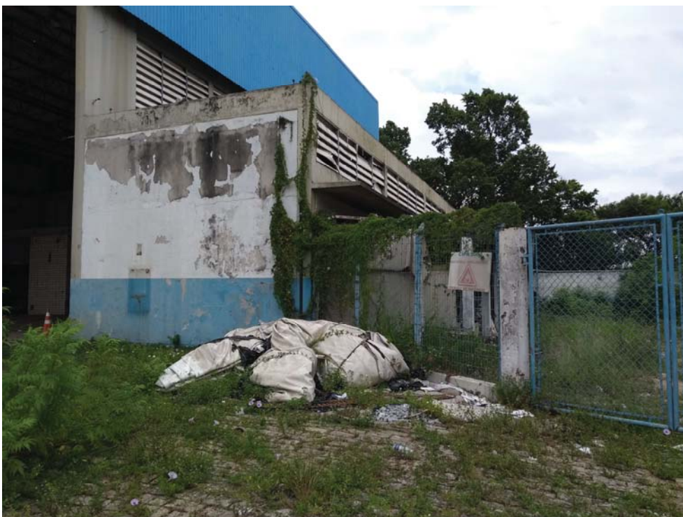
Foto 45 – Entrada da Área de inflamáveis (AF-13) ao lado da Oficina de aviões (AF-14).
