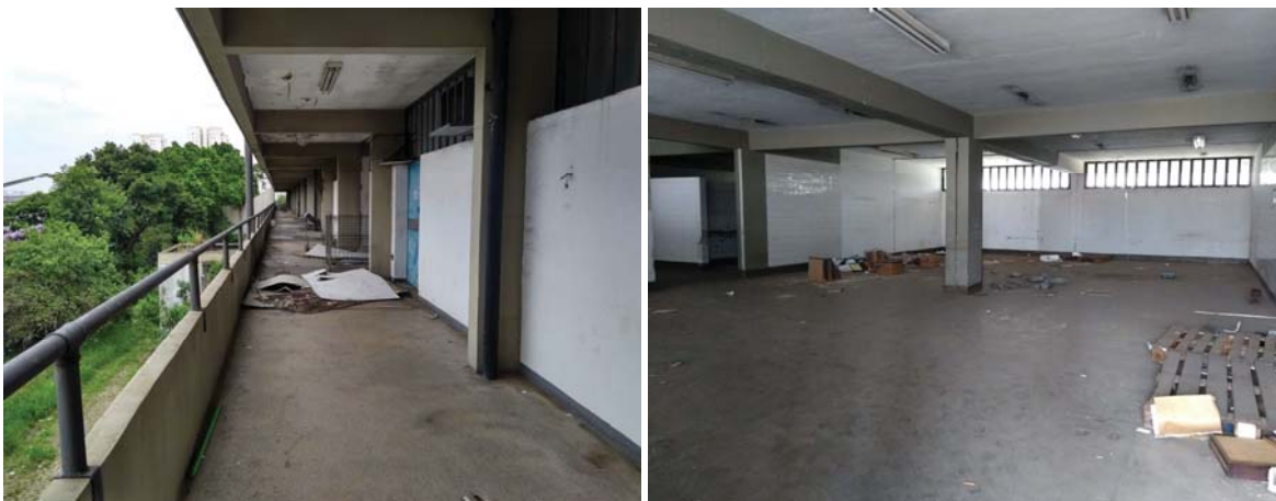
Fotos 61 e 62 – Vista do segundo pavimento da edificação, onde ocorriam atividades administrativas.
