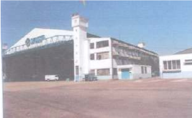
Imagem 3 – Vista frontal do Hangar I (área externa)
