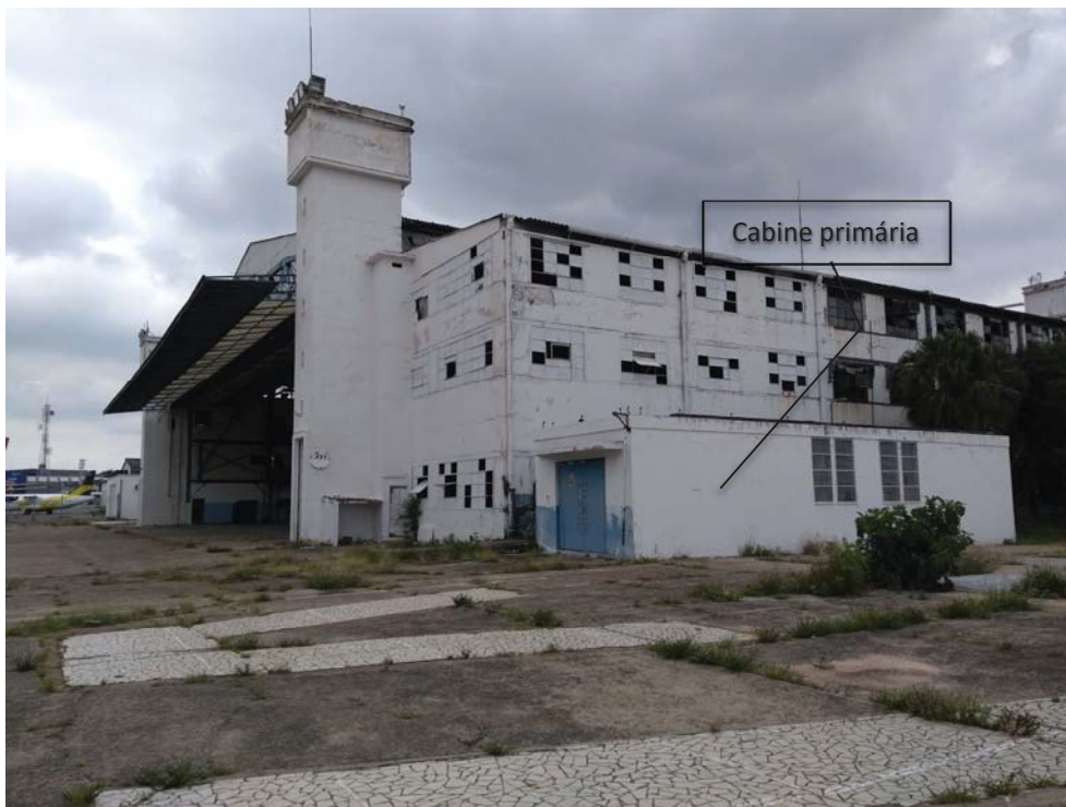
Foto 15 – Cabine primária (AF-04) ao lado do Hangar 01 (AF-01).
