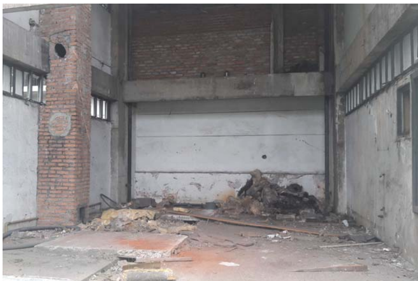
Fotos 67 e 682 – Estrutura que abrigava a caldeira e resíduos da desmontagem da caldeira.
