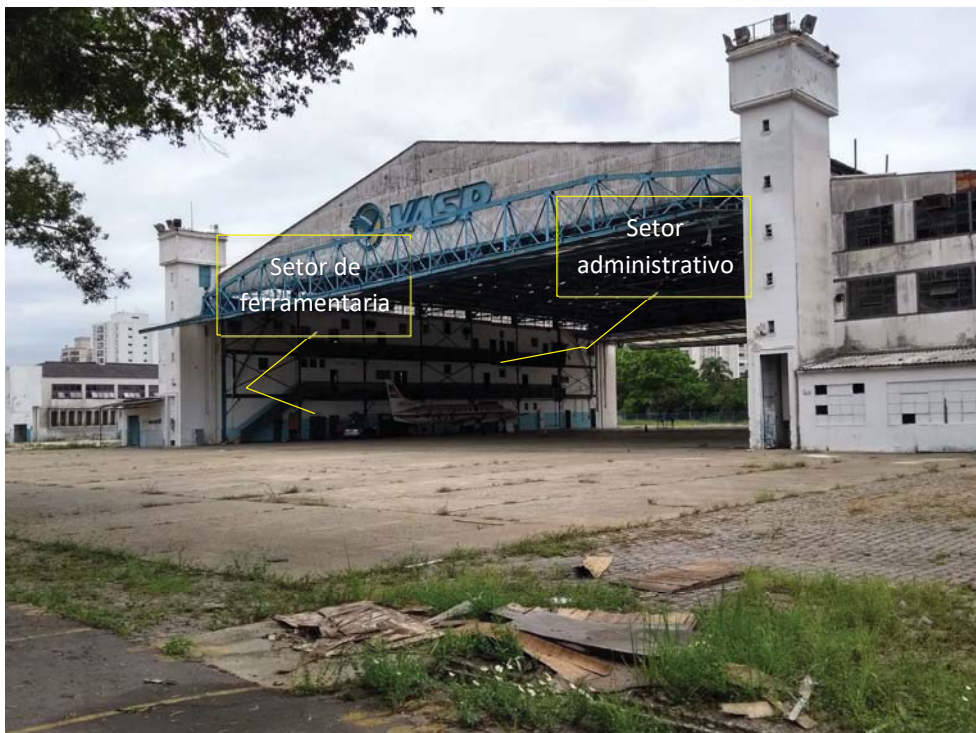
Foto 4 – Detalhe da antiga seção de ferramentaria e setor administrativo (pavimento superior).
