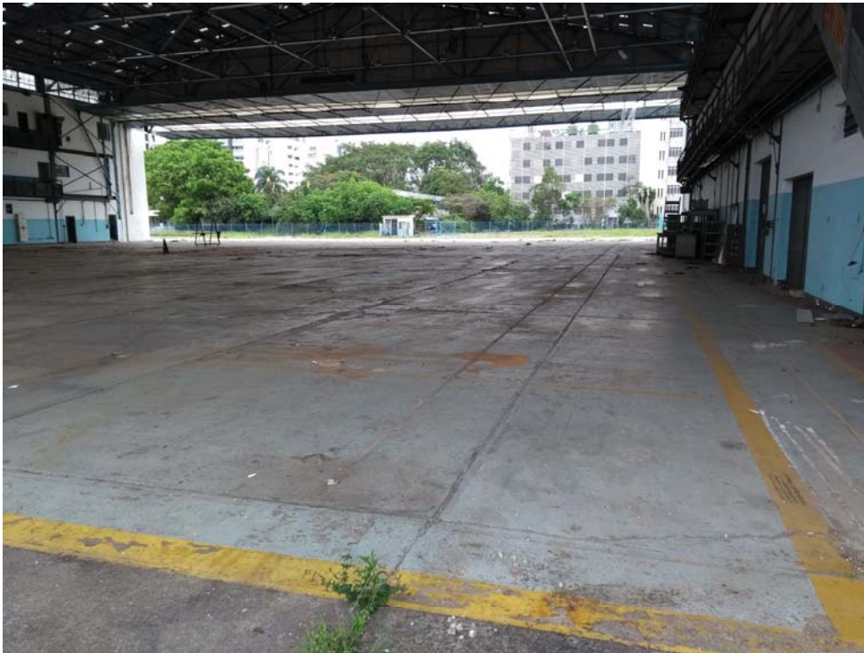
Foto 2 – Vista do Hangar I.
