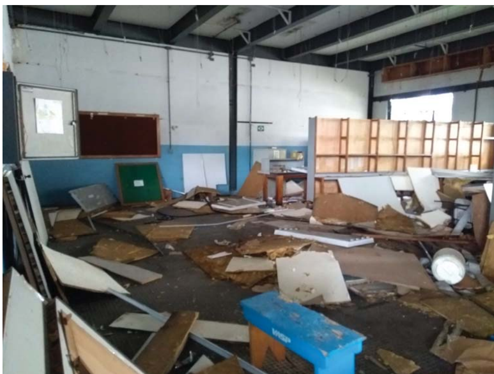
Foto 5 – Entulhos dentro do setor de ferramentaria.
