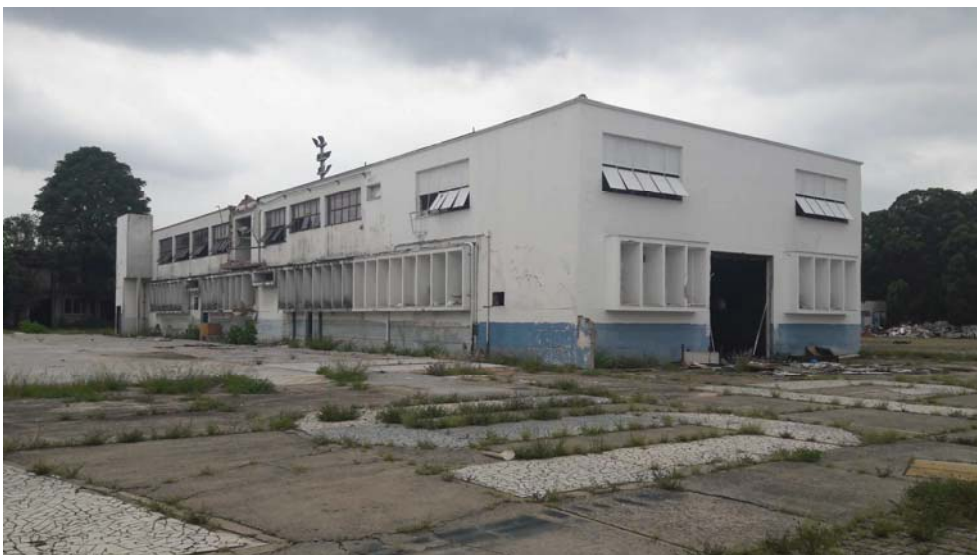
Foto 17 – Fachada da Oficina elétrica (AF-06).
