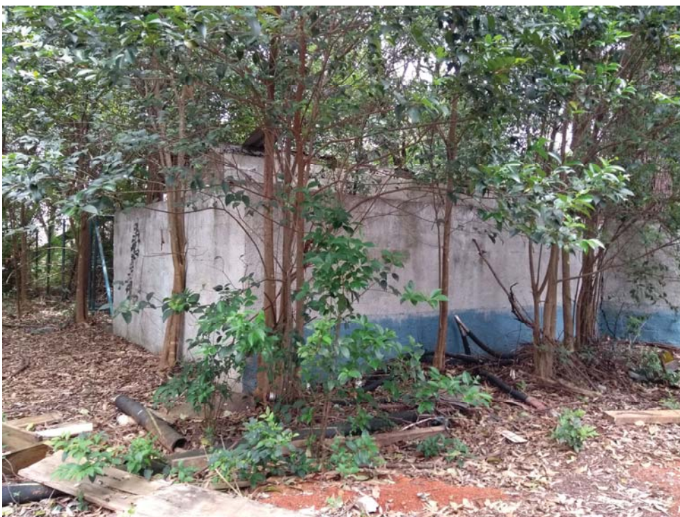
Foto 27 – Edificação onde funcionava uma lanchonete, ao lado da área de jateamento (AF-08).
