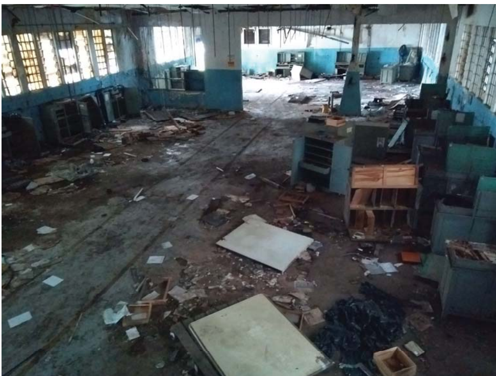
Foto 85 – Vista a partir do mezanino do setor de tornearia.
