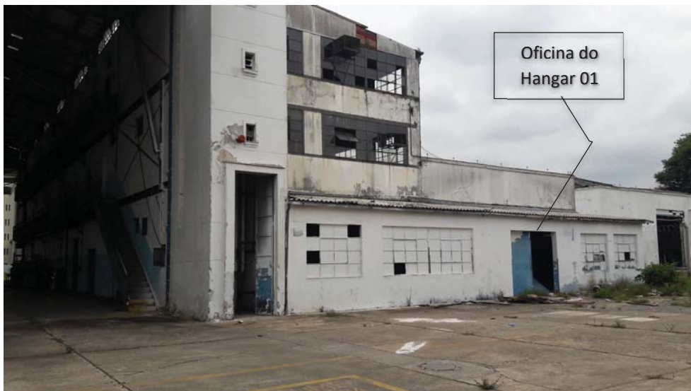
Foto 6 – Fachada da Oficina do Hangar 01.
