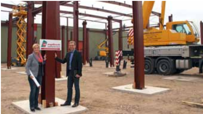
Petra Engelbrecht und Ralf Ossenschmidt-Engelbrecht, die Geschäftsführer der Engelbrecht Lasertechnik GmbH, freuen sich über den zügigen Fortschritt der Arbeiten an der neuen Produktionshalle.
