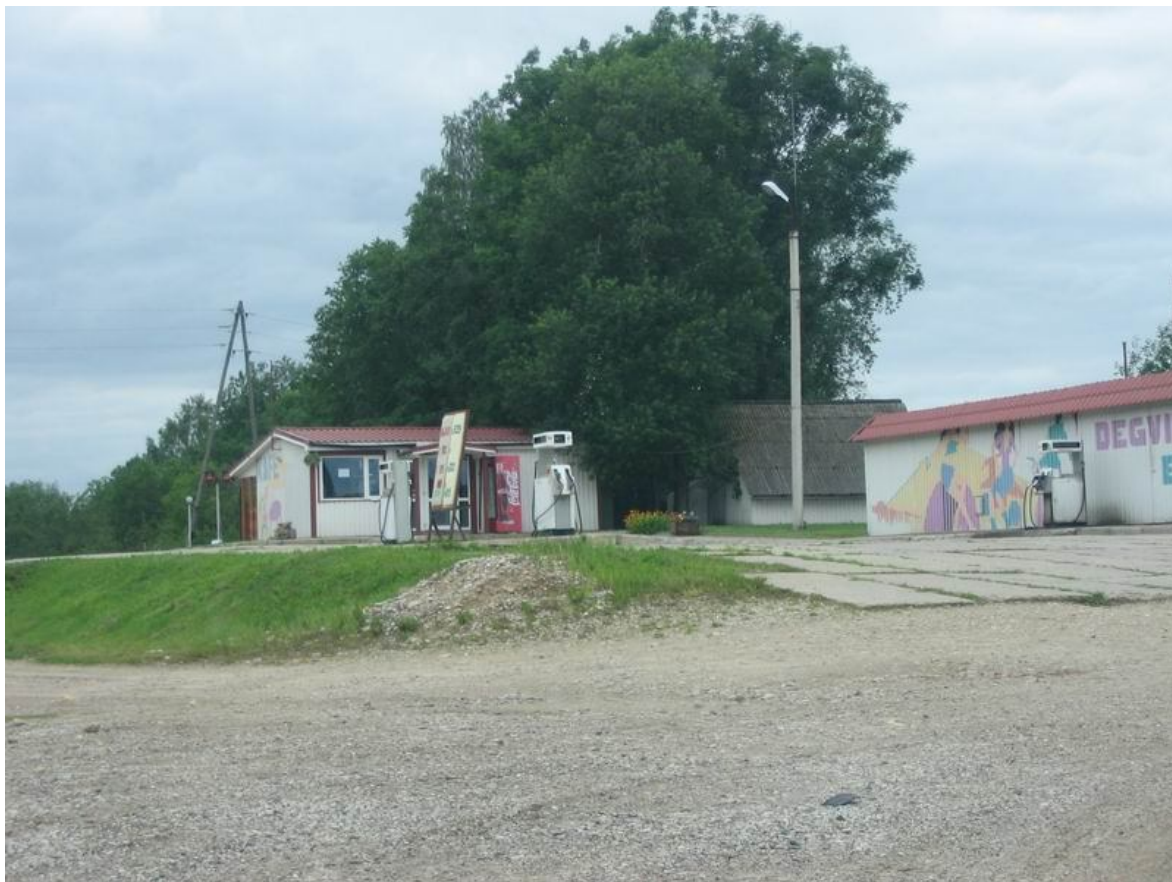
44.ATT. VECĀ DEGVIELAS UZPILDES STACIJA UN KAFEJNĪCA.
