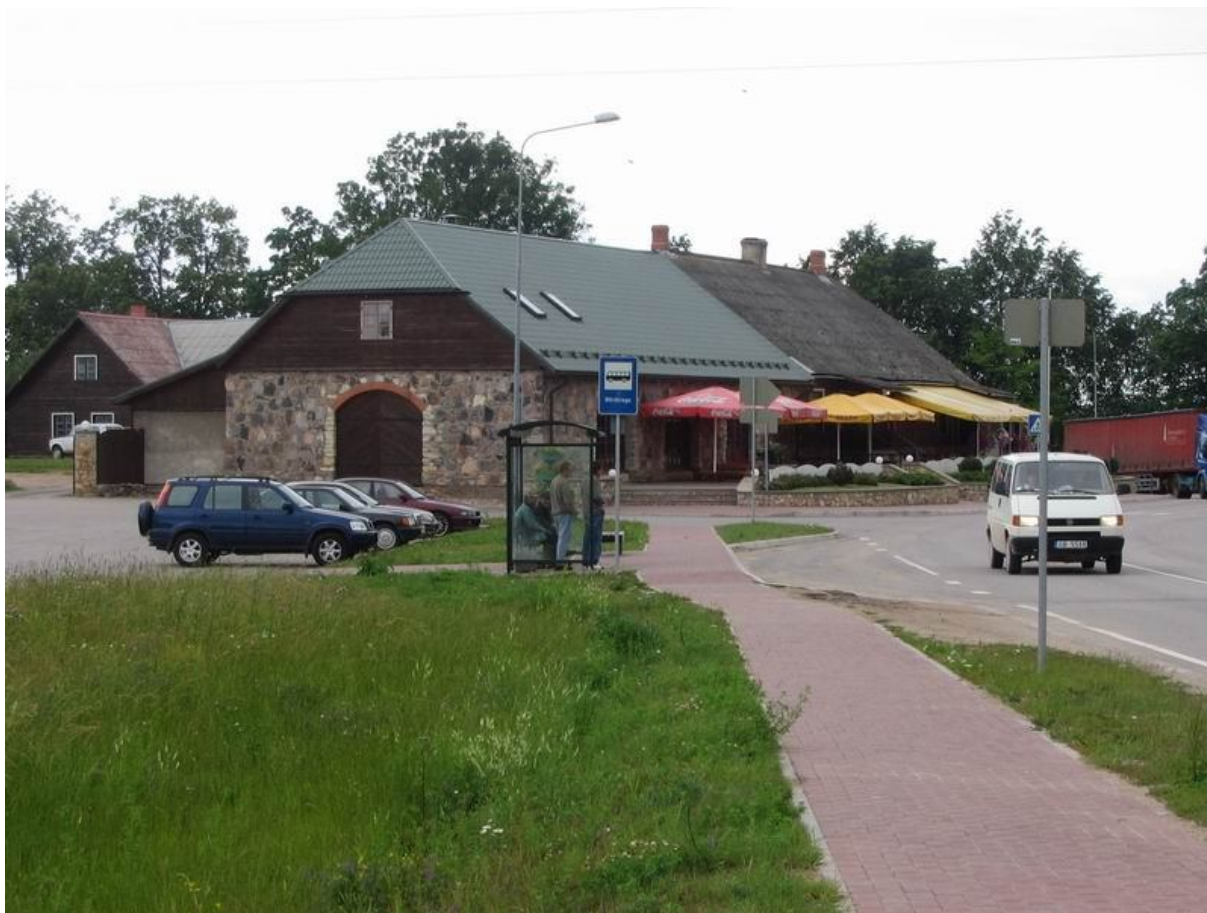
19.ATT. BĒRZKROGA ĒKA MODERNĀ BIZNESA VEIDOLĀ.
