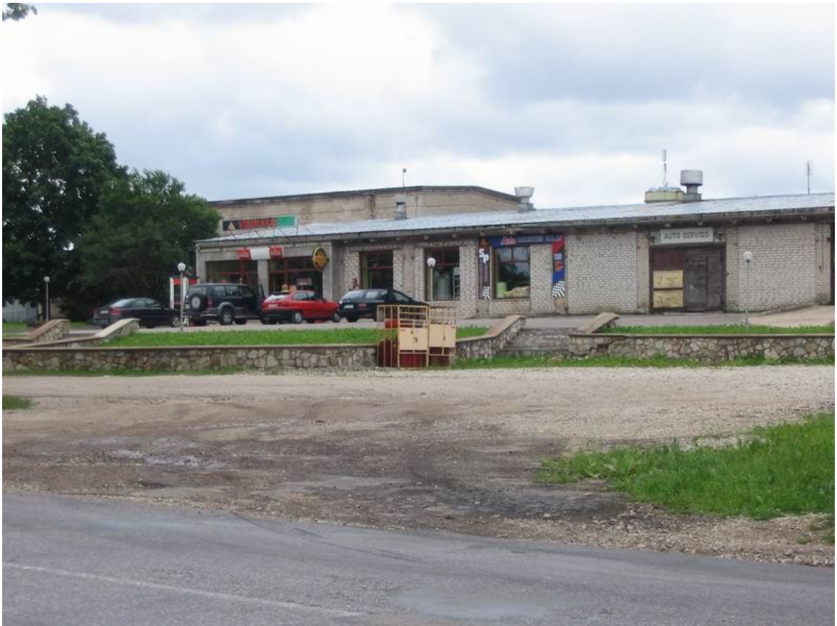
43.ATT. BĒZKROGA CENTRA DARĪJUMU APBŪVE: PADOMJU LAIKA UTILITĀRĀ BŪVNICĪBA BEZ ARHITEKTONISKAS VĒRTĪBAS, VIDI DEGRADĒJOŠS OBJEKTS.
