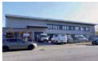
Der Oldenfelder Bogen 6 in Hamburg ist seit 2011 Sitz der 50 Mitarbeiter starken Max Siemen KG.
