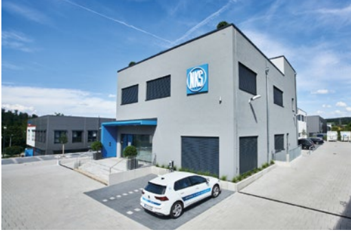
Der im Juli 2020 bezogene Neubau in Mühlthal bei Darmstadt bietet insgesamt 2.300 m 2 für 60 NKS-Mitarbeiter.
