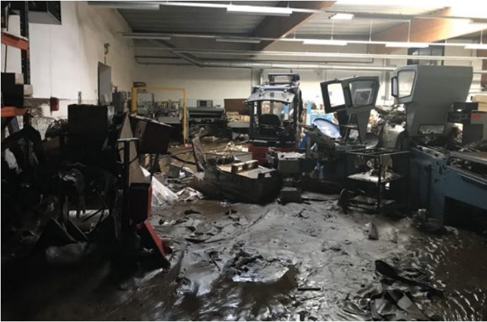
So sah es in den Produktionsräumen von Kliemo direkt nach der Katastrophe aus. Sämtliche Maschinen und Lagerbestände wurden zerstört.
