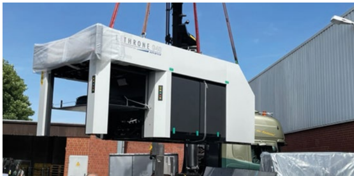
Auslage am Haken: Das Foto entstand bei der Installation der Komori G40.
