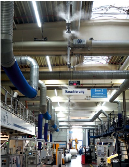
Direkt-Raumluftbefeuchter schützen vor Elektrostatik im Produktions- und Verarbeitungsprozess bei B+K.
