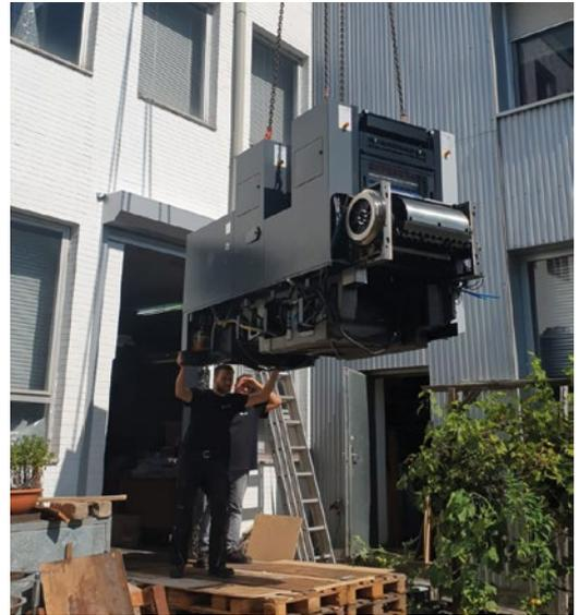
Aribas-Monteure bugsieren ein Teil der Druckmaschine durch ein Loch in der Wand in den Drucksaal, nachdem ein Kran es über das Gebäude hinweg gehoben hatte.
