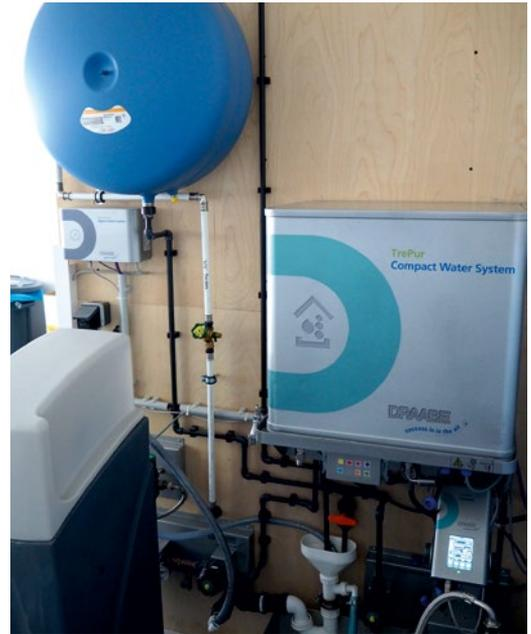
Wasseraufbereitung mit mobilem Service-Container, der halbjährlich zur Wartung getauscht wird.
