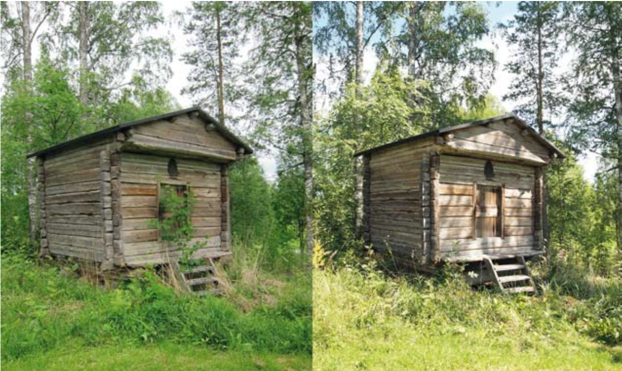
Rakennuksen viereen kasvaneet puut ja pensaat kannattaa poistaa, jottei rakennus pääse vaurioitumaan eikä jää kasvillisuuden piiloon. Nyrkkisääntönä voi pitää, että kasvillisuus pidetään vähintään puolen metrin etäisyydellä rakennuksista.
