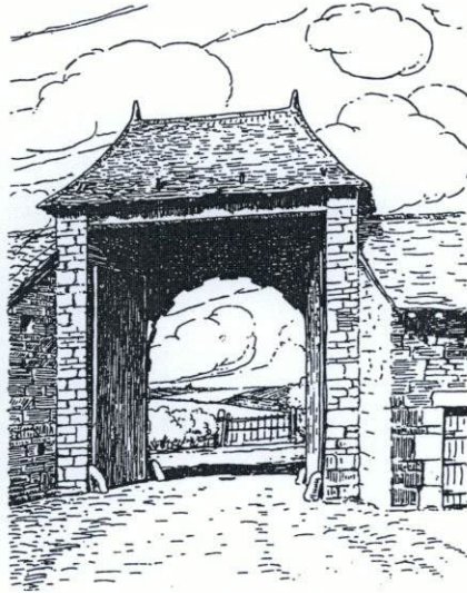
Fig. 687 : teûté protégeant la porte d'une cour de ferme.
