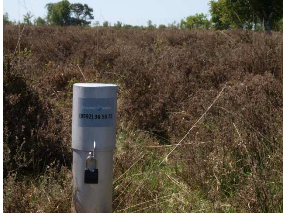
Waterpeilbuis: meten is weten (foto: Hans Dekker)
