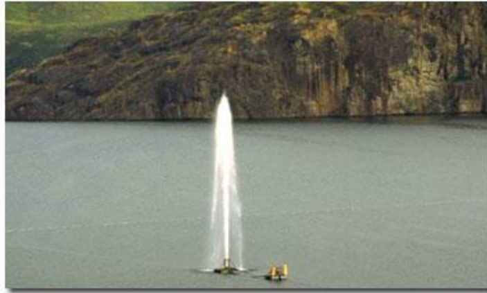
Figure 13 : Système de dégazage artificiel du Lac Nyos
