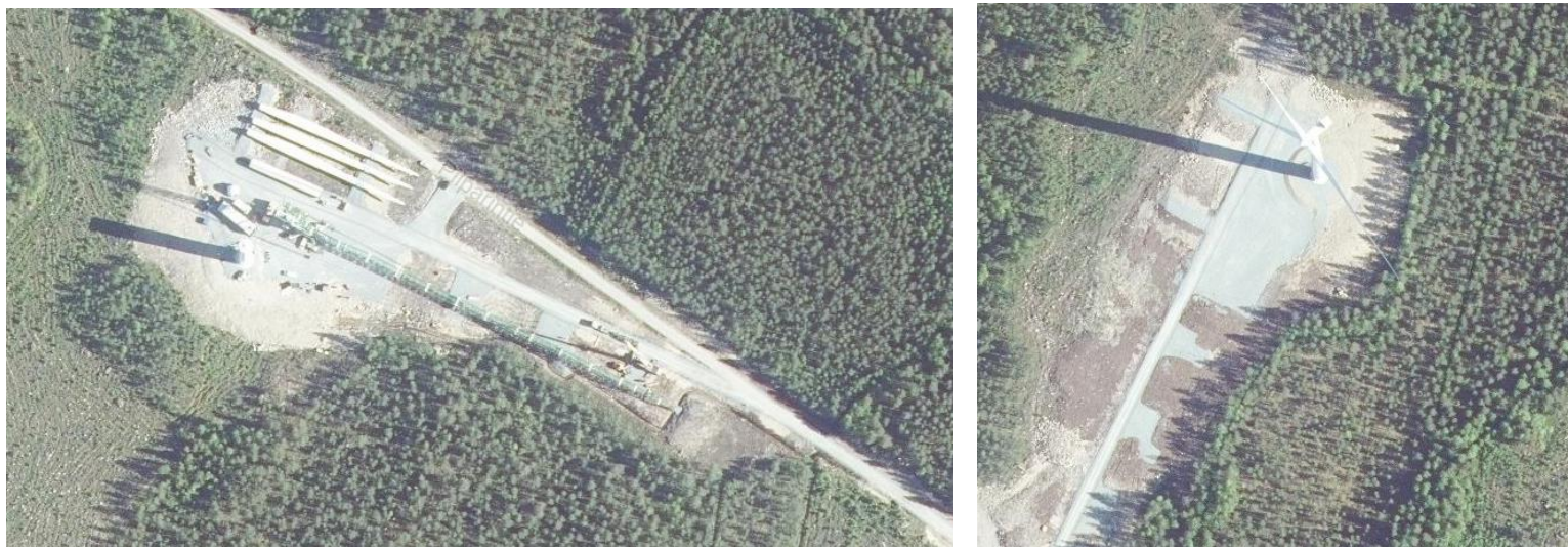
Kuva 6. Esimerkki tuulivoimalan vaatimasta aukeasta. Ilmakuva Pyhännän Piiparinmäen tuulipuistosta voimaloiden pystytysvaiheessa (Ilmakuva © MML 2022).
