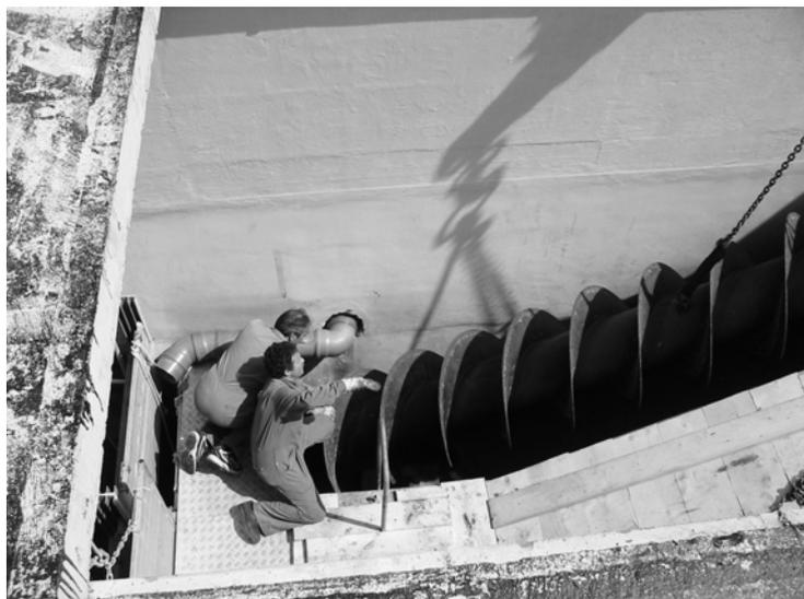
Pose de la nouvelle vis de relevage à la station Chamblandes
