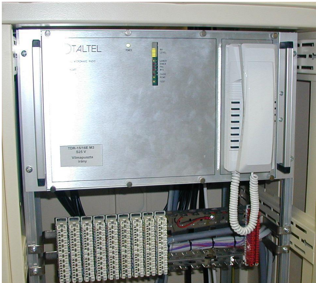
A legelső beltéri egység Veszprém hírközpontban 1993-ban. Jobb oldalon a szolgálati telefon. 4x2 Mbps, Vilma pusztai irányon
