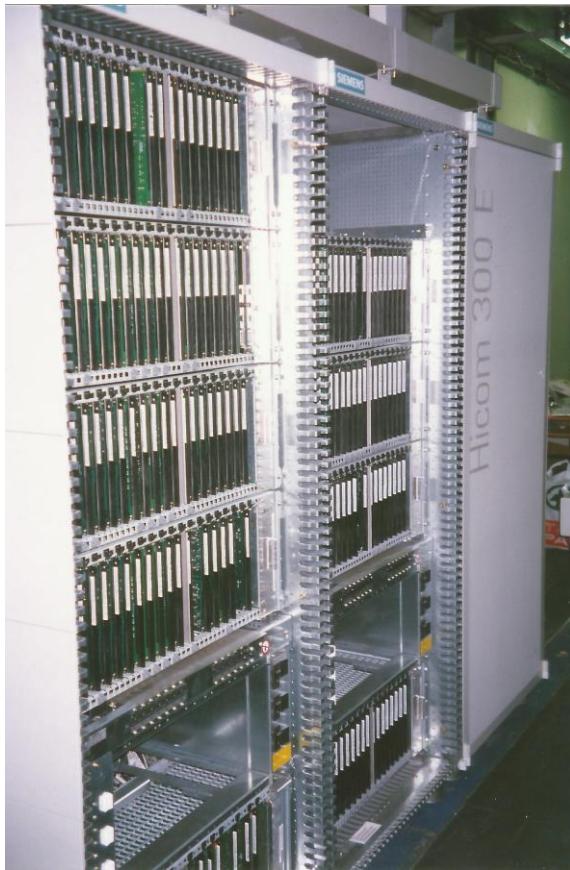
Komplett Hicom-330E a HM-II hírközpontban HM-I 2. szekrény előlnézetben[4]
