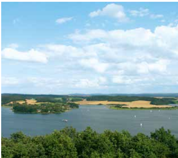
Talsperre Pöhl. Foto: T. Harbig
