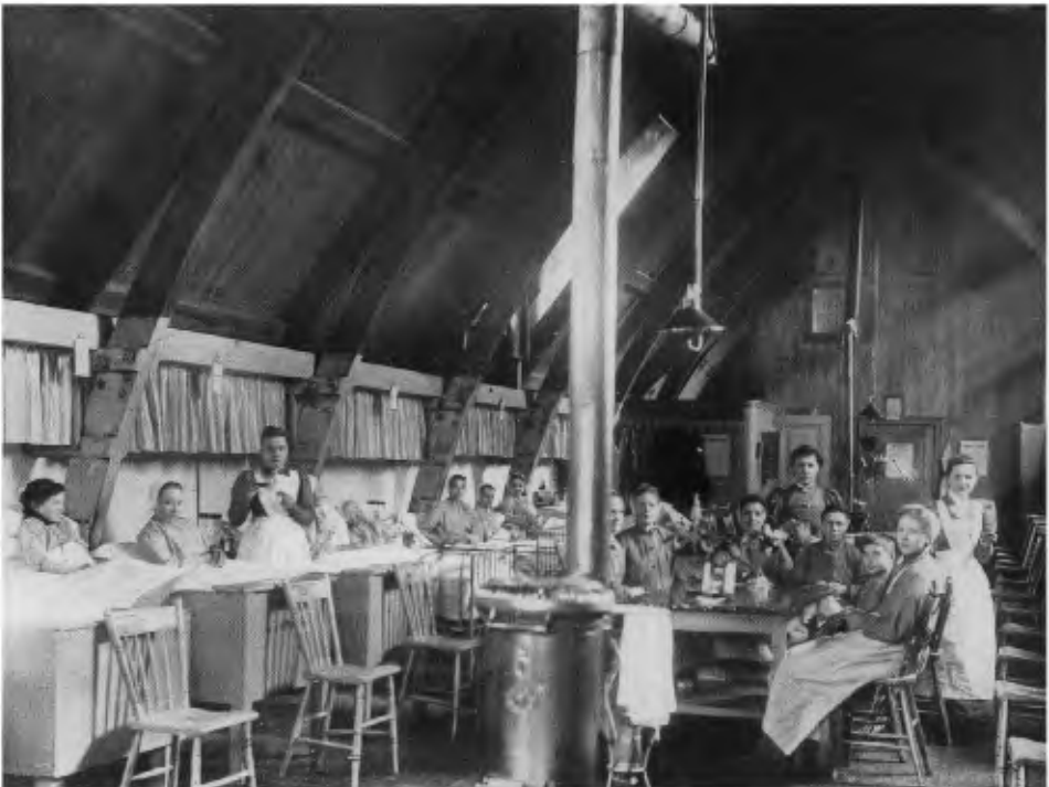
De uit 1851 daterende zolderzaal -'t omgekeerde schip- van het Vrouwenverband in het Binnengasthuis te Amsterdam, vóór de afbraak in 1897.
