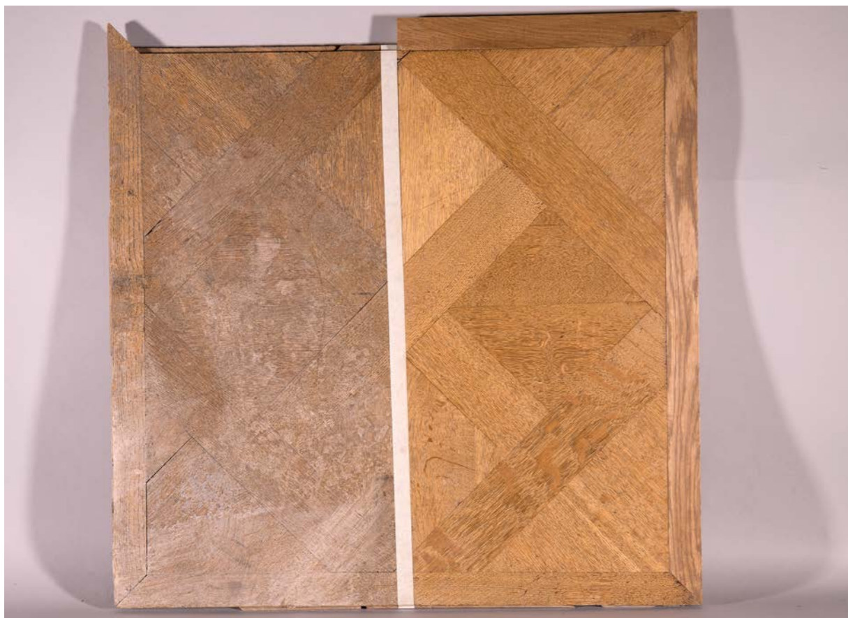
Původní degradovaný dubový parketový dílec (jednovrstvý). Polovina dílce vyčištěna a ošetřena tradiční metodou. Restaurátorská dílna Hulač.
