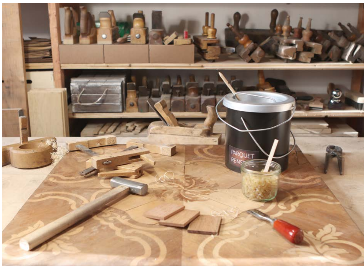
Nářadí a lepidlo (klijh), oprava zámeckých parket v dílně.
