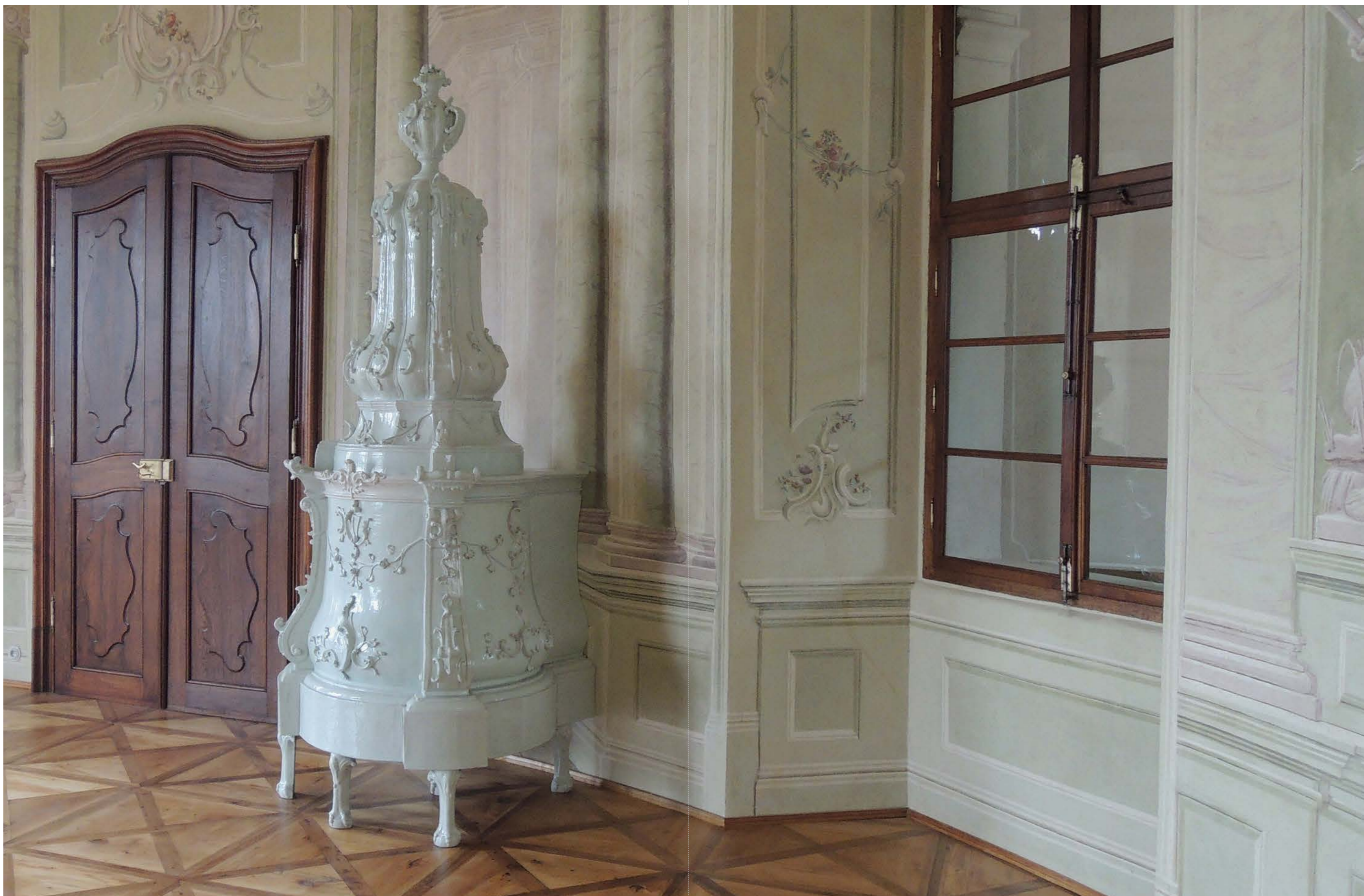
Kamna po kamnářské rekonstrukci a závěrečném spárování. Foto Sylva Antony Čekalová, Michal Raušer.
