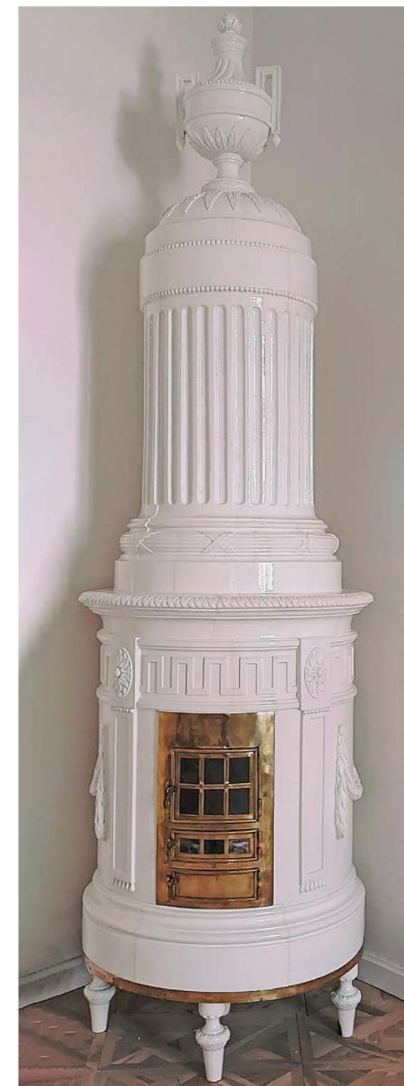
Celek kachlových kamen před a po provedení zásahů. Kamna byla v minulosti používána, pravděpodobně před rokem 1926 byl kamnům demontován kouřovod (několik fotografií v Archivu hl. města Prahy ukazuje, že před jinými kamny v objektu byla osazena kovová tělesa typu Meteor či americká kamna, napojená na kouřovody stávajících keramických kamen).
