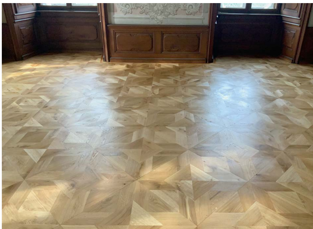
Zámek Vizovice, replika zámeckých parket, tradiční pokládka přitloukáním, povrchová úprava barevných voskem na zestaršení a bezbarvým jako finální povrch.
