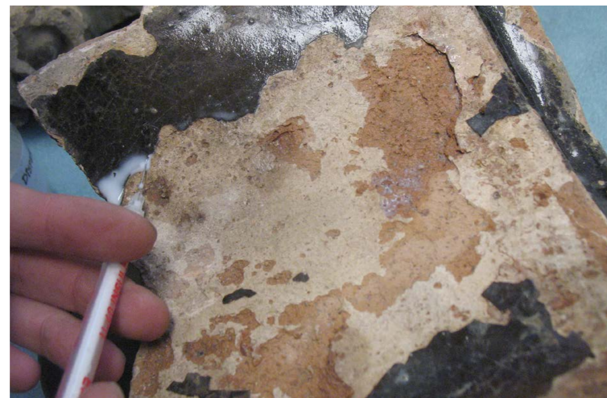
Konsolidace uvolněné glazury: Místa s narušenou soudržností glazury byla konsolidována pomocí 10% roztoku Dispercollu D2 a destilované vody. Roztok byl opakovaně aplikován na povrch štětce a pod uvolněnou glazuru pomocí injektáže. U míst s výrazně pozvednutou glazurou, kde bylo nutné vyplnit větší dutinu, byl použit 5–10% roztok Paraloidu B72 v acetonu. Ten je možné použít u tmavých kamen. U světlých transparentních glazur může způsobit barevné změny – mapy zvýrazněním podkladu pod glazurou.
