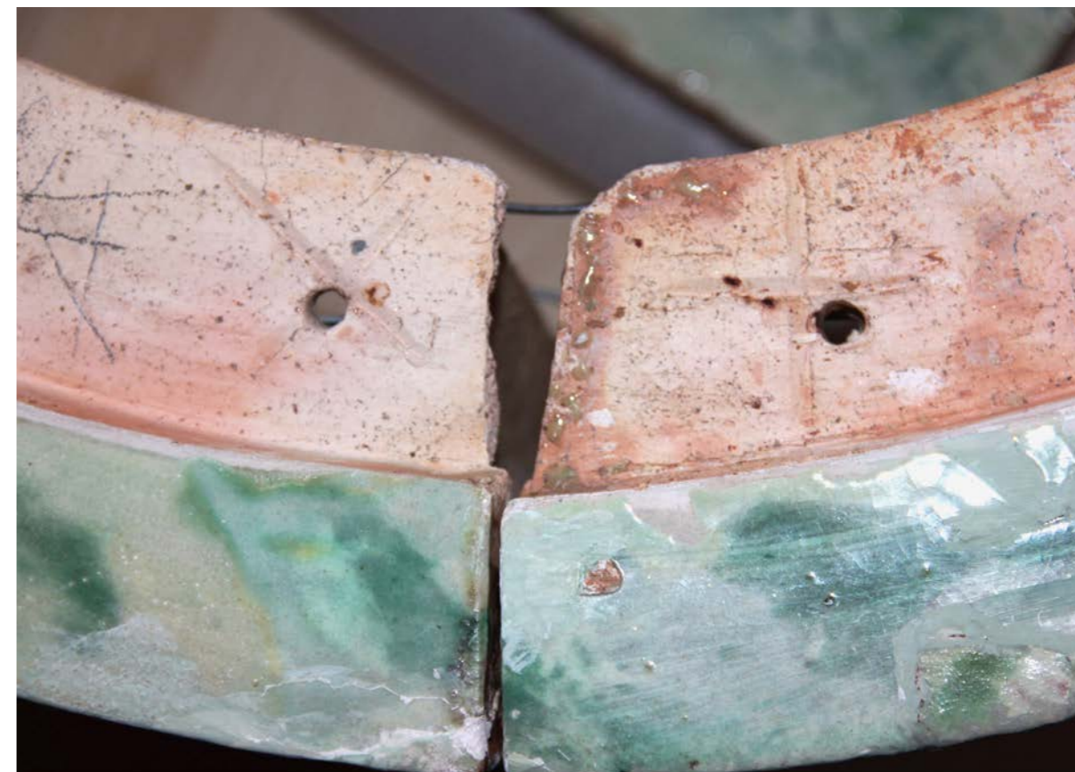
Původní kamnářská stavba lokálně nerespektovala kamnářské výrobní značení, které slouží pro sestavení kachlů přesně k sobě. Kachle tak musely být při současné rekonstrukci v rámci řad uspořádány správně a přečíslovány tak, aby k sobě kachle přesně seděly.
