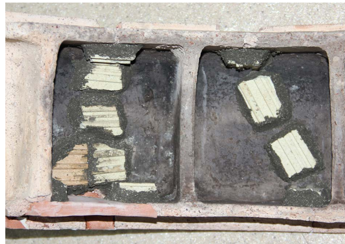
Jištění prasklin a rozlomených částí pomocí šamotových plomb pojených ke keramice vysokopecním tmelem měkčeným říčním pískem. Spoje jsou jištěny kvůli snadnější reverzibilitě pouze v místech prasklin, nikoli v celé ploše. Velikost plomb je volena menší, aby šly snadněji odklepnout v případě nutnosti budoucího rozlepení. Foto Radka Bukovjanová.
