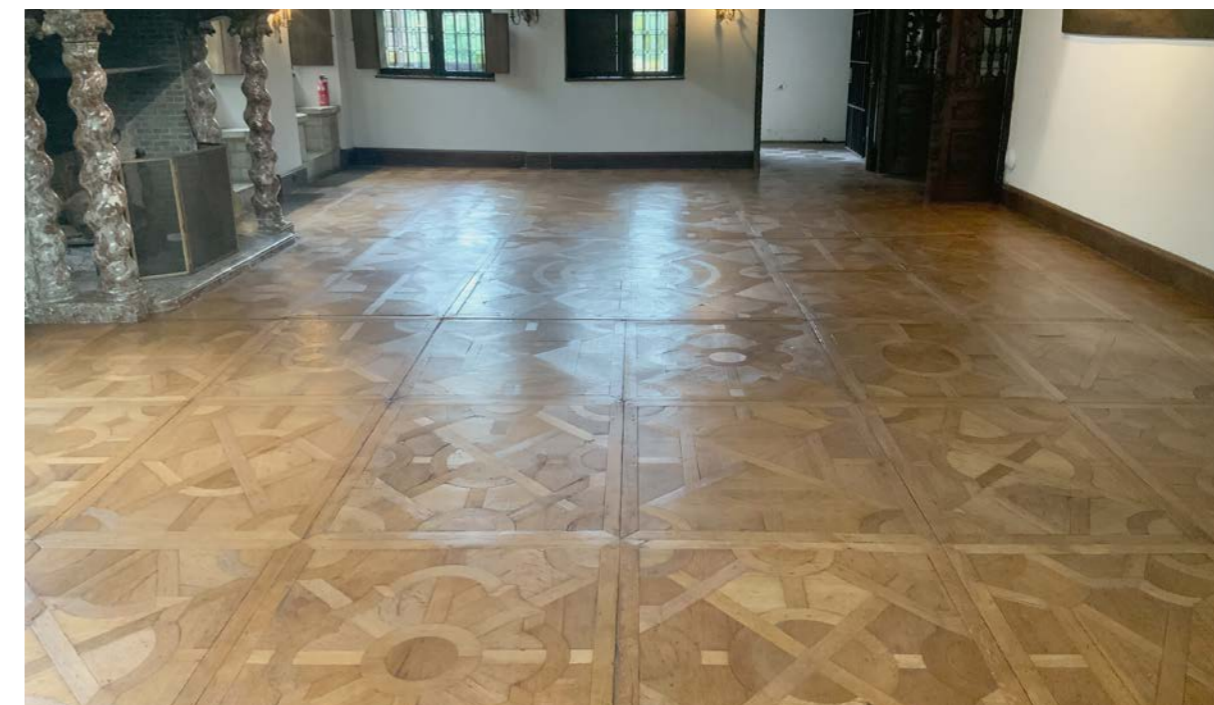
Zámek Groot Bijgaarden, Dilbeek, Belgie, restaurování parket, čištění, povrchová úprava bezbarvým vosk.
