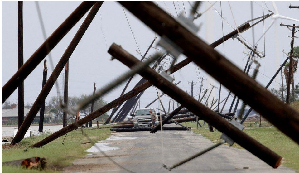
图 3-24: 飓风“哈维”期间，德克萨斯州塔夫特附近被击落的电线。 125
