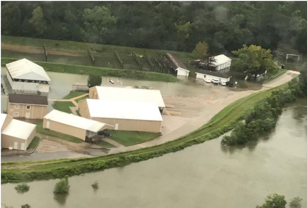
图 3-23: 飓风“哈维”期间康罗市的污水处理厂。 85
