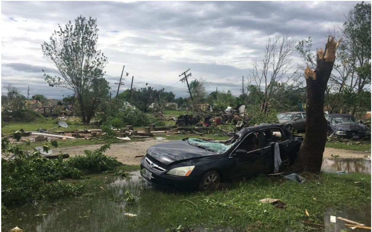
图 3-50: 2019 年 4 月富兰克林市龙卷风造成的损害。 242
