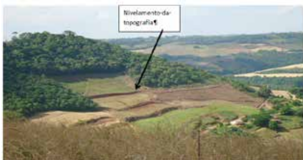
Figura 7 - Construção de nivelamento da topografia do relevo
