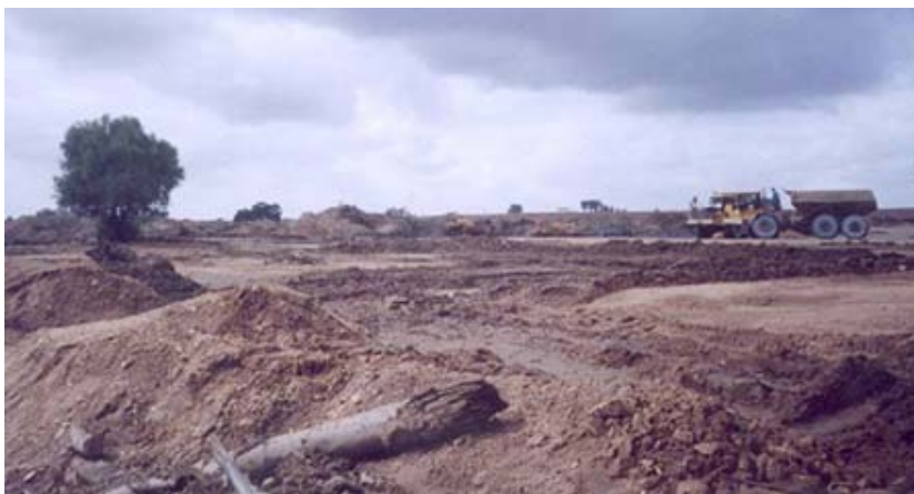
Figura 2. Proceso de limpieza del lodo pirítico con maquinaria pesada.
